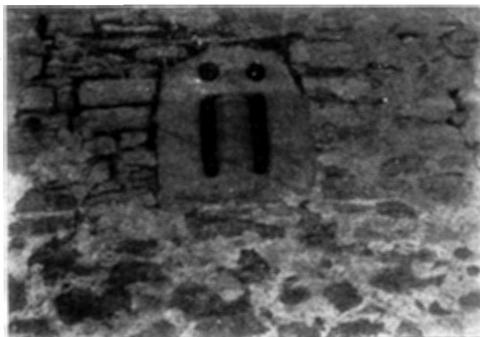
Foto 7 — Ventana de San Lorenzo de Bermejillo
