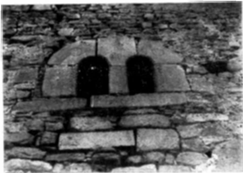
Foto 8 — Ventana geminada de la torre de Sobrado
